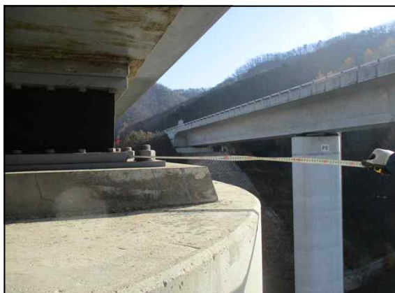
교량받침 연단거리 측정 현황
