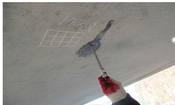
b. 탄산화 깊이 측정
