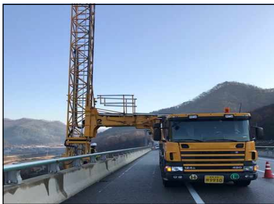
작업차량을 이용한 외관조사
