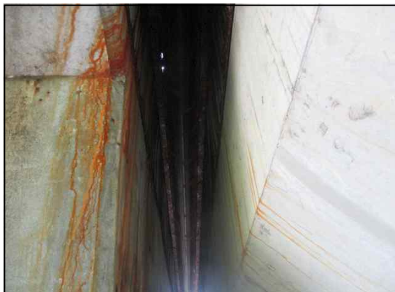
신축이음 상부 유간 전경(A1)
