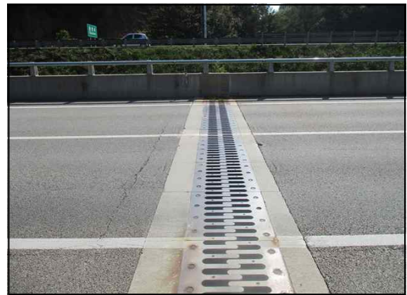
신축이음 상부 전경(A2)
