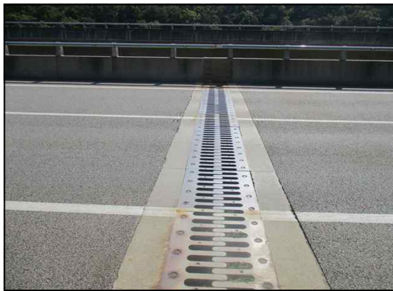
신축이음 상부 전경(A1)
