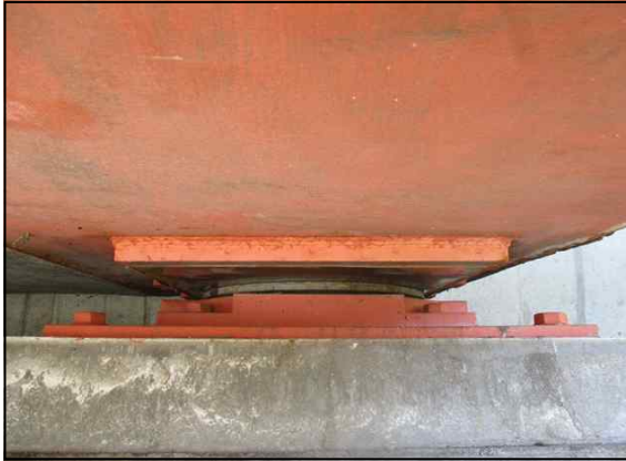
교량받침 전경(A1 SH1)
