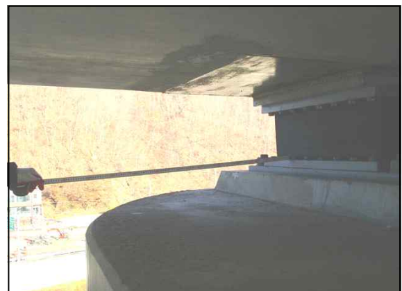
교량받침 연단거리 측정 현황
