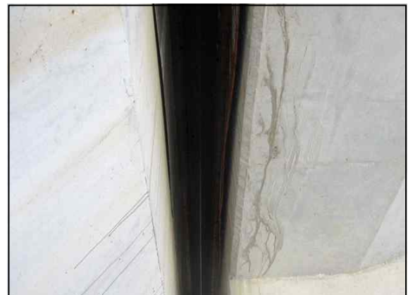
신축이음 하부 유간 전경(A2)
