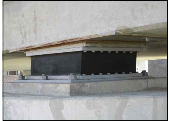
교량받침 전경(P7 SH1)
