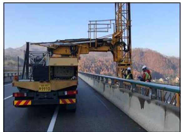
작업차량을 이용한 외관조사
